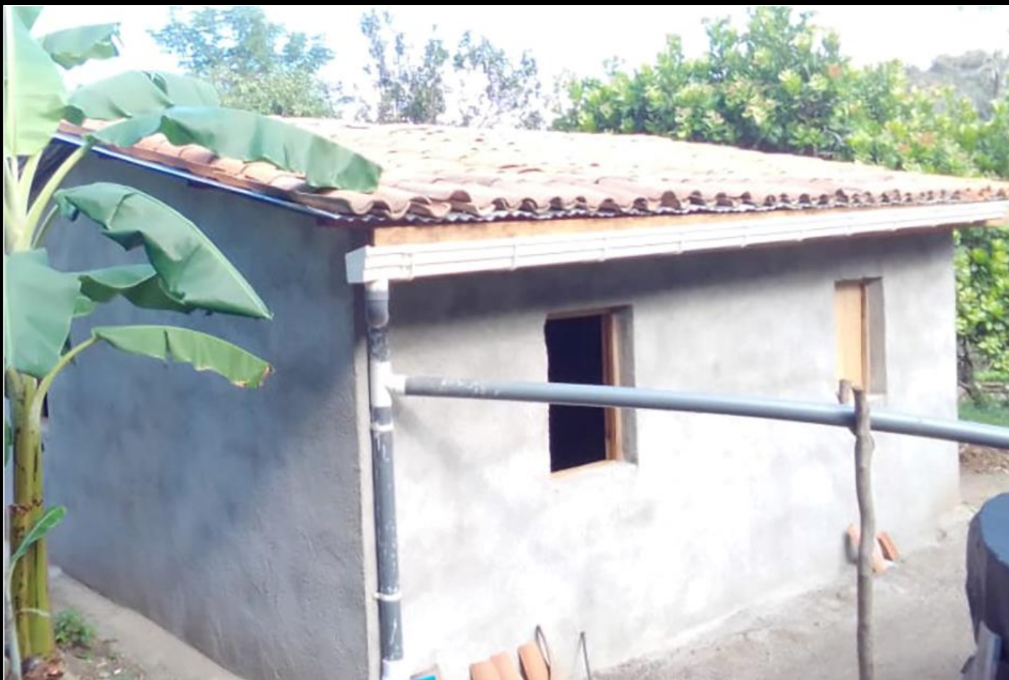
Tanque recogida agua de lluvia
