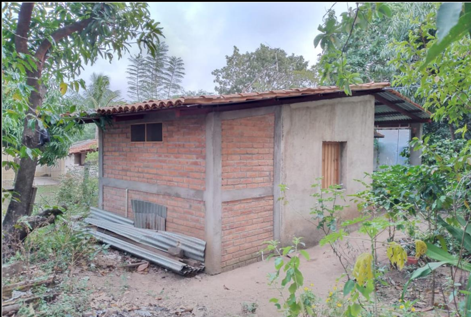
Casa nueva Baño añadido
